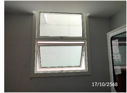
ช่องระบายอากาศ Fireman Lift
